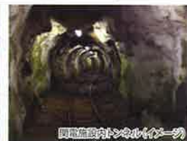
関西電力施設内トンネル(全長約100m)
